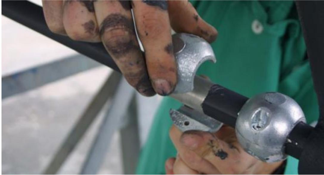
*Ne pas peindre la partie métallique en contact avec l'anode.*
